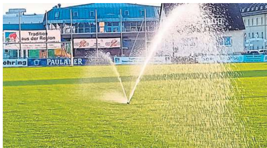
Die neue Beregnungsanlage.
