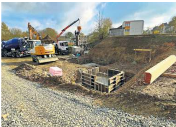
Regnitzlosau: Neubau der Kindertagesstätte geht gut voran
