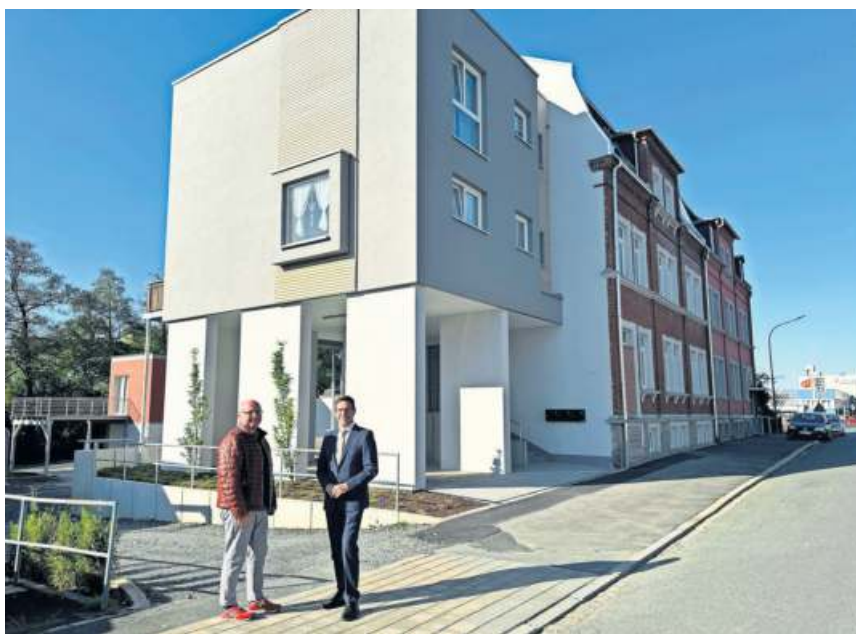
Matthias Stingl (links) mit Bürgermeister Michael Abraham vor dem sanierten Gebäude Goethestraße 25. Dahinter ist das neu gebaute Einfamilienhaus zu erkennen.
