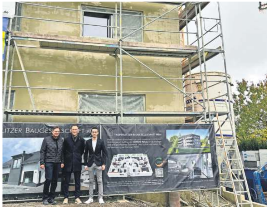
GEWOG-Geschäftsführer Jürgen Becker, Geschäftsführer der Tauperlitzer Baugesellschaft Dominik Wißkott sowie GEWOG-Geschäftsführer Thomas Riedel vor dem Neubau im Reutlichweg.
