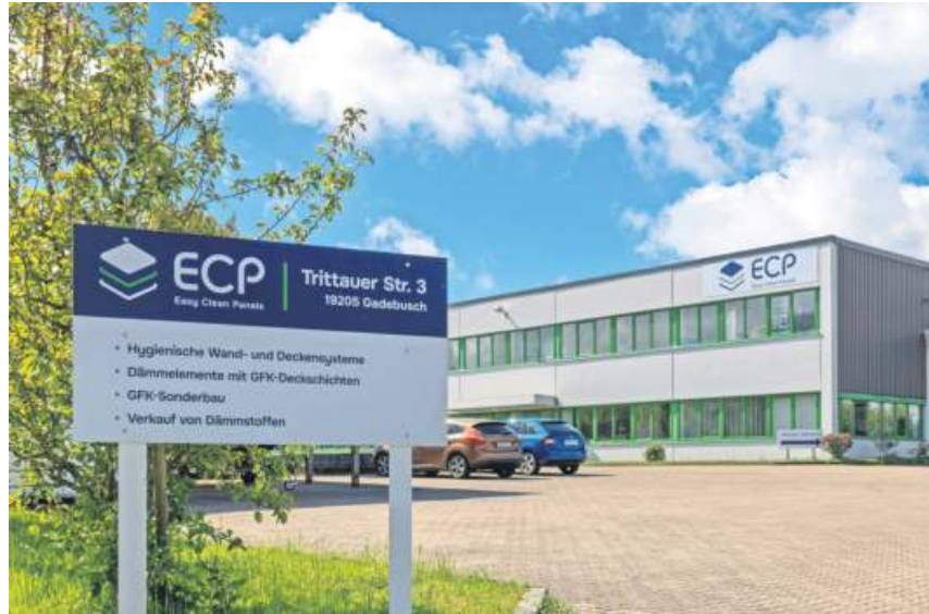
Der Standort der ECP Gesellschaft für GFK-Systemlösungen mbH im mecklenburg-vorpommerschen Gadebusch wird Teil der LAMILUX Gruppe. Das Unternehmen entwickelt und produziert hygienische Wand- und Deckensysteme unter anderem für die Lebensmittelindustrie.
