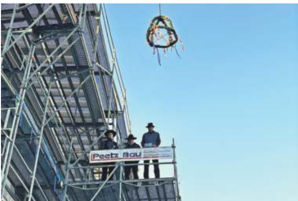
Rehau: Richtfest für den Bauteil H des Schulzentrums
